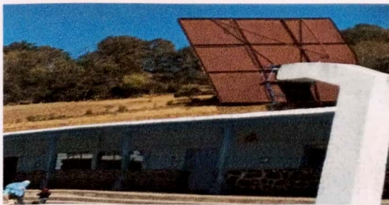
Foto 5: SUSTITUCION DE VIDRIOS
