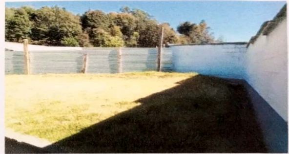
Foto 4: PINTURA EN MUROS EXTERIORES E INTERIORES
