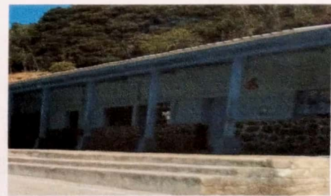
Foto 6: SUSTITUCION DE VIDRIOS
