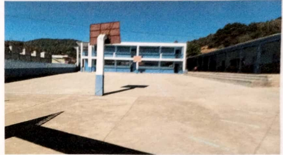
Foto 2: PINTURA EN MUROS EXTERIORES E INTERIORES
