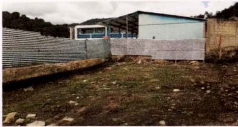
Foto 3: PINTURA EN MUROS EXTERIORES E INTERIORES
